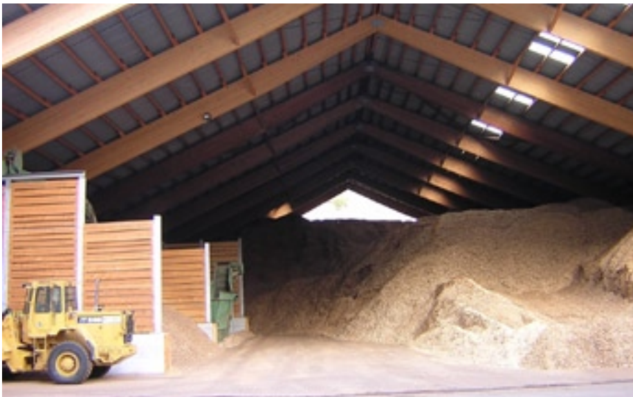
Das Holzschnitzen-Zwischenlager von Courchavon liegt nördlich von Pruntrut.
