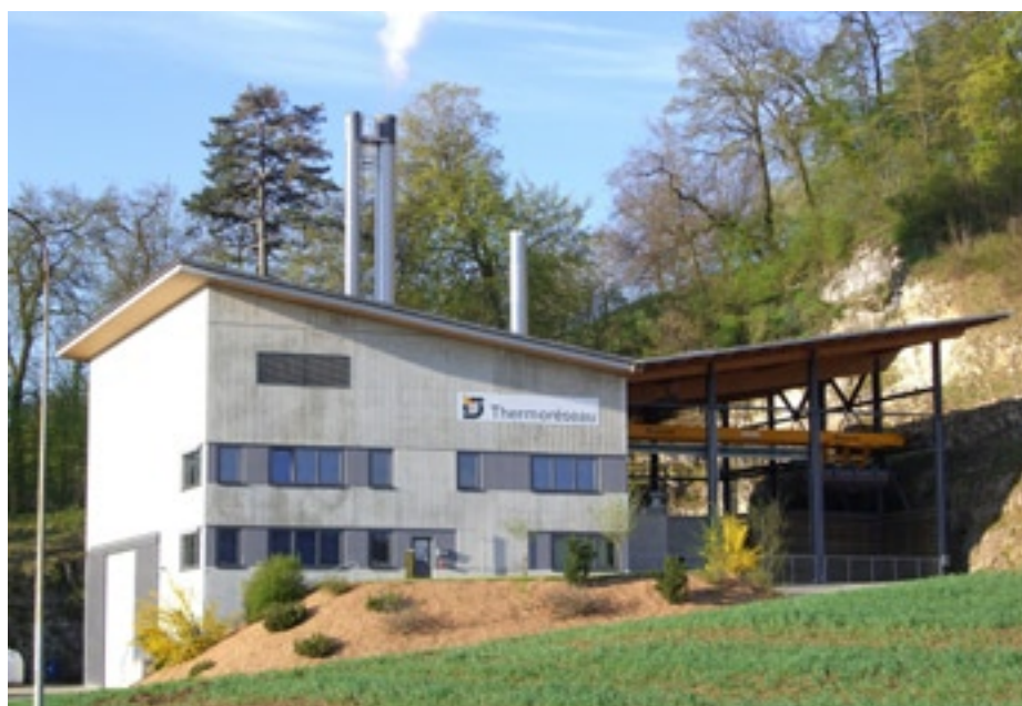
Die Heizzentrale «Bellevue» an der Rue de Belfort.
